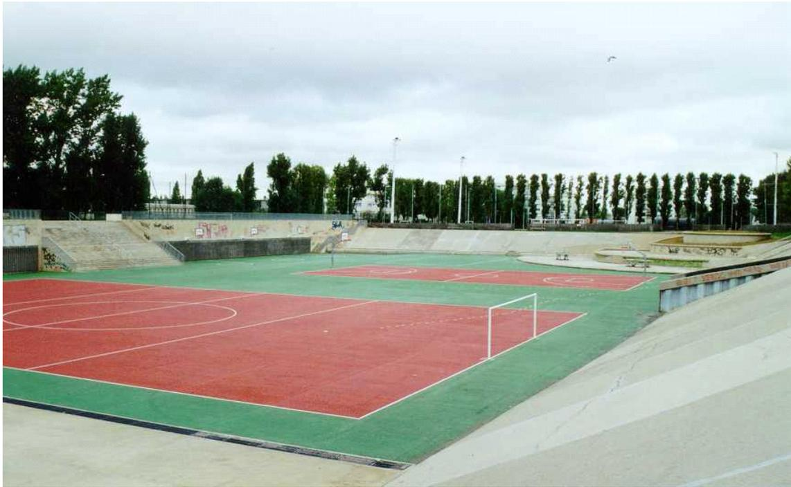
Figura 3.17 – Exemplo de bacia de retenção seca, combinada a quadras de esporte
