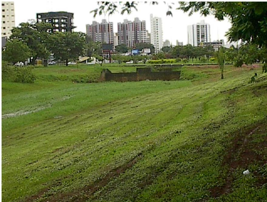
Figura 3.16 – Exemplo de bacia de detenção seca, combinada a uma área verde.
