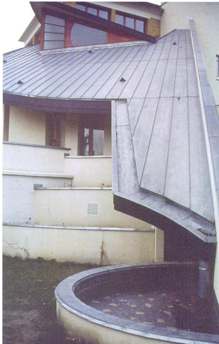
Figura 3.2 – Armazenamento em nível do solo: microreservatório de águas pluviais.
