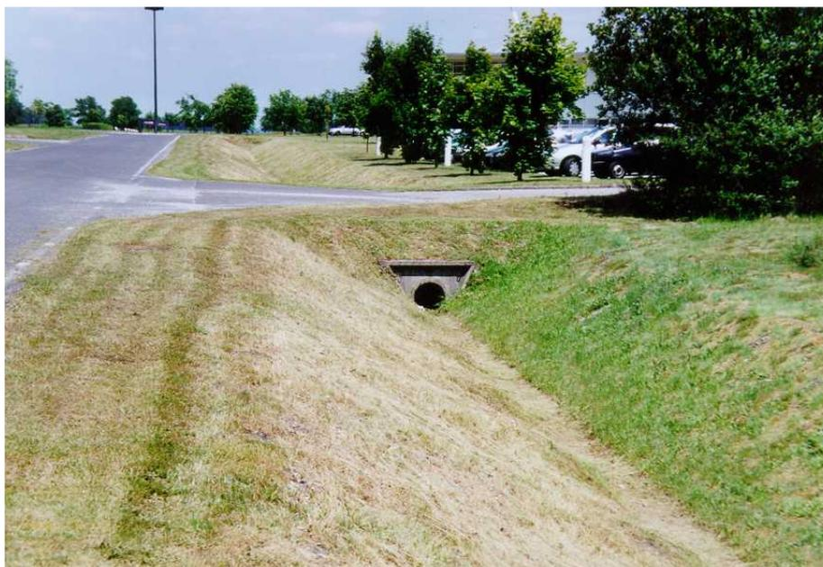
Figura 3.9 – Valeta de armazenamento e infiltração
