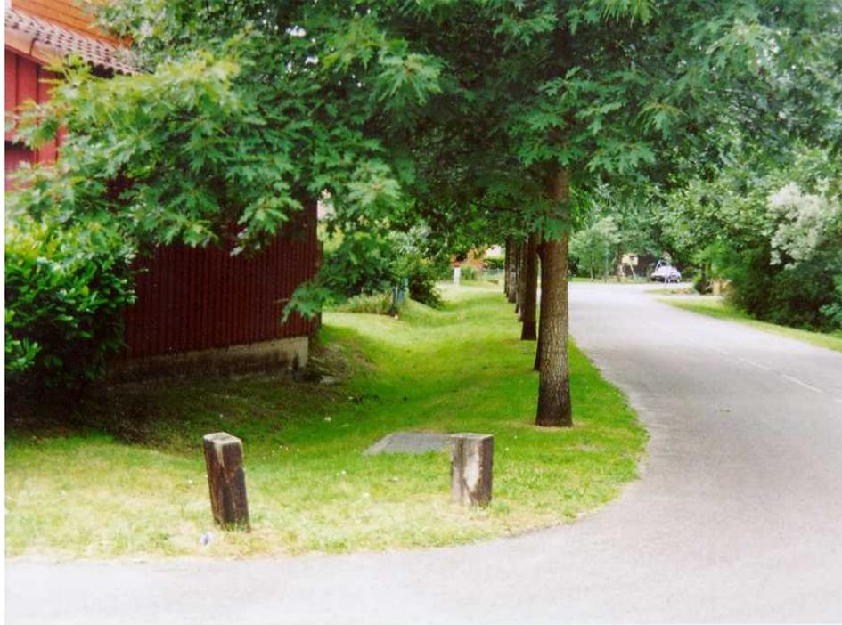
Figura 3.8 – Valeta de armazenamento e infiltração
